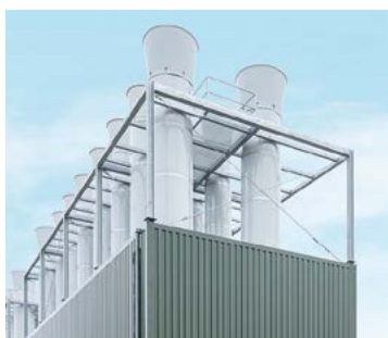
Klimatyzacją, ogrzewaniem i chłodzeniem
